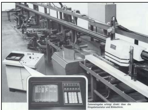
Bild 1.3: Die erste Abbundanlage (Firma Burmek 1984) 5
