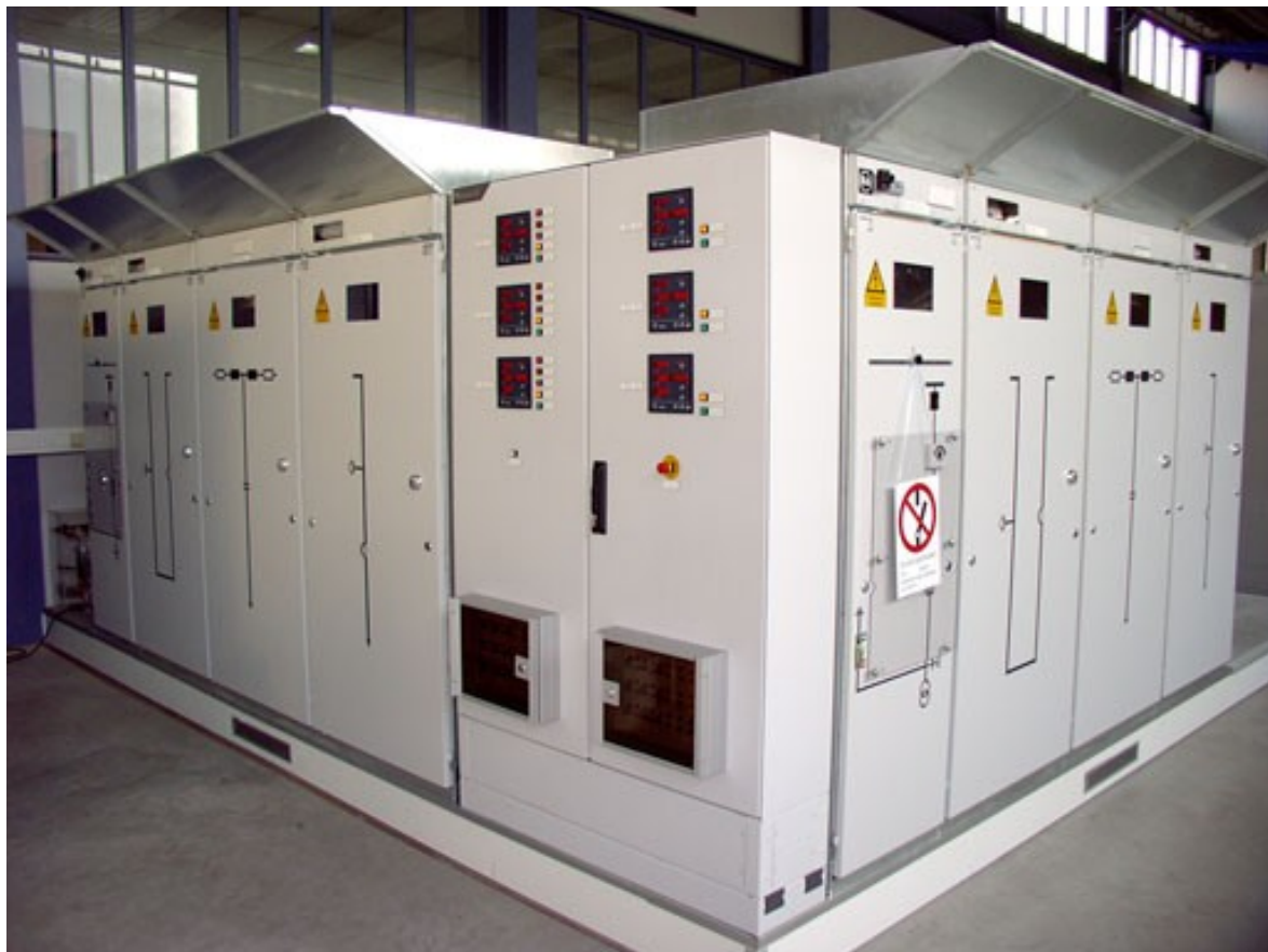
Bild 4.5: Ausführung der Mittelspannungsnetznachbildung im DeMoTec des ISET
