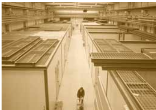
Die 1962 errichtete Henschel-Halle K 1 wurde in das neue Technik-Gebäude I/II integriert. [Quelle: 1]
