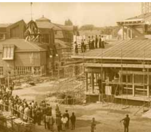
Richtfest an der Mensa [Quelle: 1]
