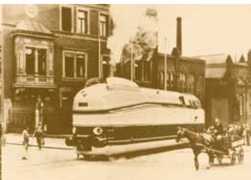
Eine Schnellfahrlokomotive des Henschel-Wegmann-Zuges verlässt das Werk. Die Lokomotive konnte Geschwindigkeiten bis zu 175 Stundenkilometer erreichen. Die dazugehörigen Waggons produzierte die Firma Wegmann in Rothenditmold, um 1935. [Quelle: 2]
