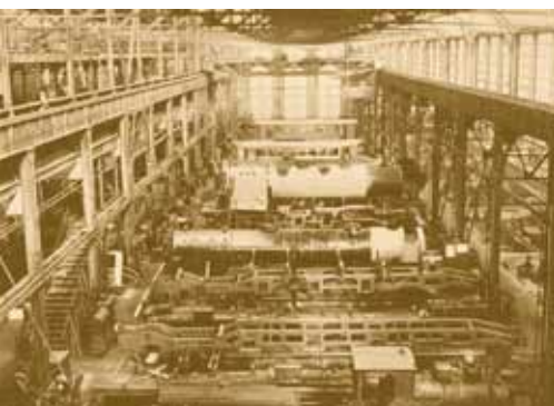
In der Richthalle werden die Henschel-Lokomotiven montiert, um 1935. [Quelle: 2]
