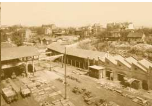
Blick auf den Werkschhof und die Verladehalle, um 1935. [Quelle: 2]
